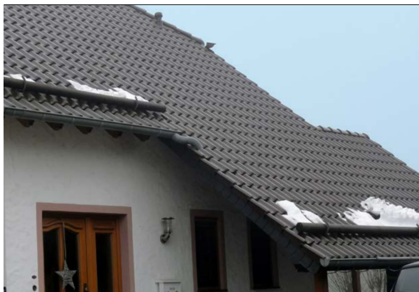
Schneestoppvorrichtung zum Schutz vor Dachlawinen
