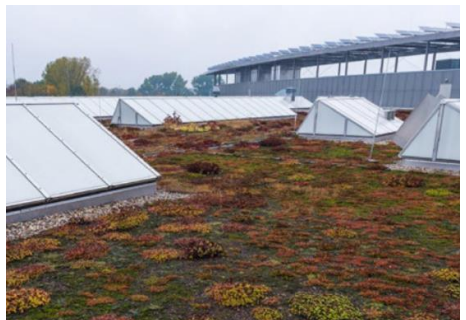
Extensive Dachbegrünung (© KWB/Andreas [FranzXaver] Süß)
