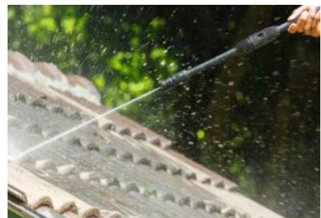
Mechanische Reinigung von Dachziegeln (© OST)
