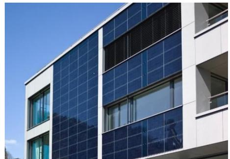
Fassade mit integrierten Solarzellen (© OST)
