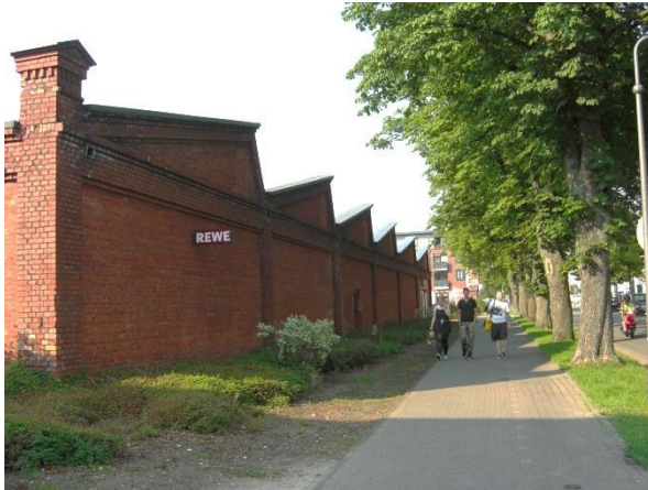
Shedfassade des Verbrauchermarkts. Am rechten Bildrand verläuft die Berliner Straße .
