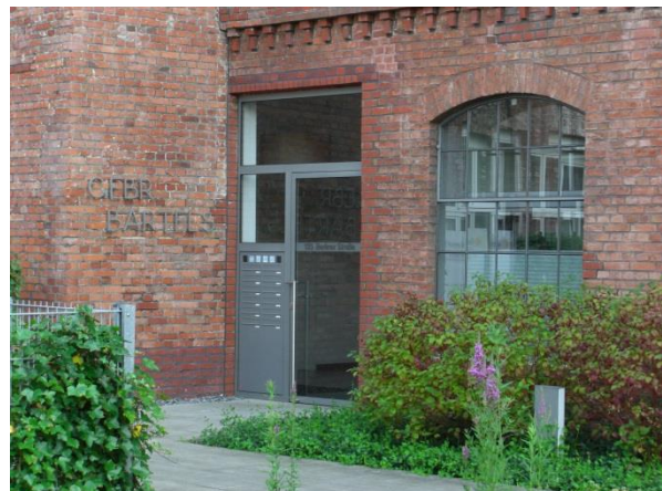
Eingangsbereich des ehemaligen Polizeigebäudes. Die Räumlichkeiten wurden zu Loft-Wohnungen ausgebaut.
