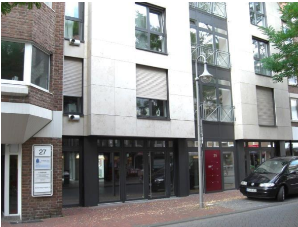
Der Eingangsbereich des Neubaus. Die Sandsteinfassade wird – entgegen der Anregung des Beirats – auf Höhe des Erdgeschosses nicht fortgesetzt.
