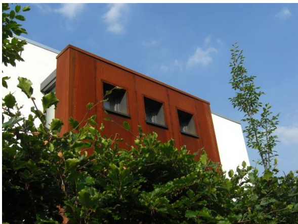
Eines der individuell gestalteten Einzelhäuser.
