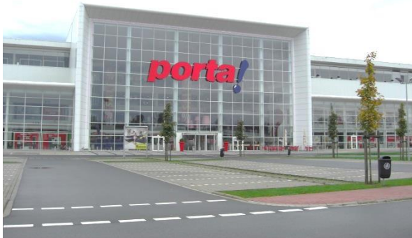
Der quaderförmige Portikus des Porta-Möbelhauses. Die Einzelbäume gründen auf den Zeichnungen des Freiflächenkonzepts.
