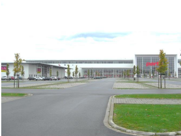
Kundenparkplatz. Die Stellplatzfläche dient sowohl den Besuchern des Möbelhauses Porta als auch des Discounters SB-Möbel Boss und Gartencenter Brockmeyer .
