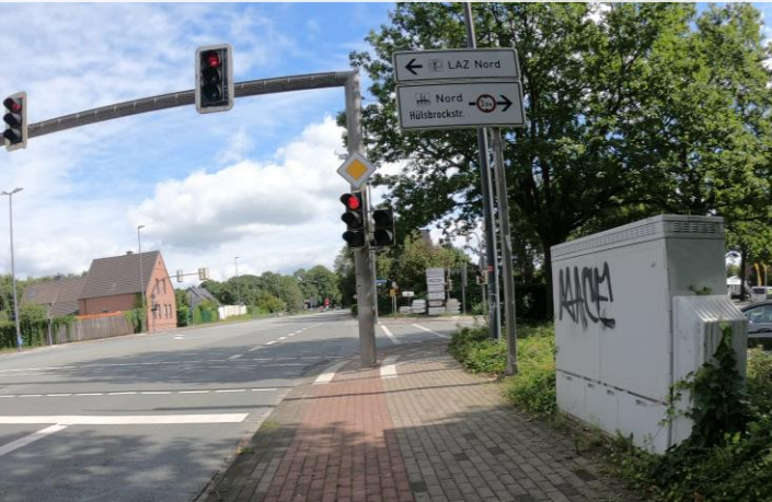
Signalmast - Berliner Straße
