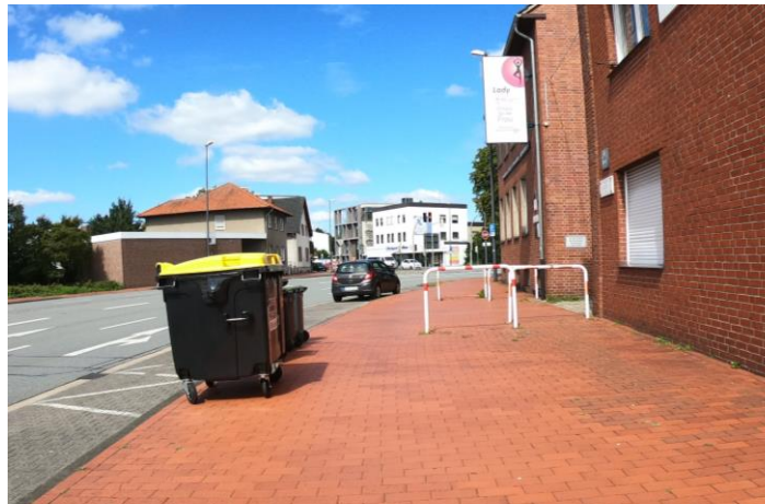
Umlaufsperrung - Verler Str.
