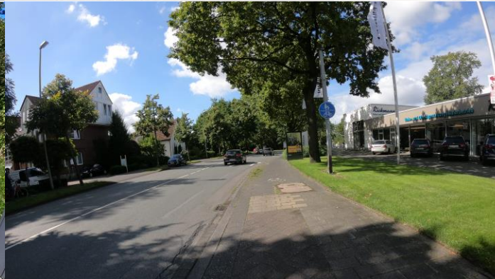
Gemeinsamer Geh-/Radweg mit Benutzungspflicht (Einrichtungsverkehr) – Wiedenbrücker Str.
